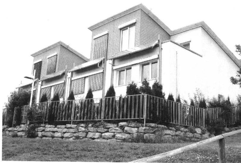
图1-6 集热器安装在遮阳板上 (摄影 张磊)
