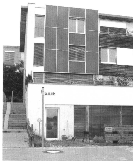
图1-5 集热器安装在墙面上 (摄影 张磊)
