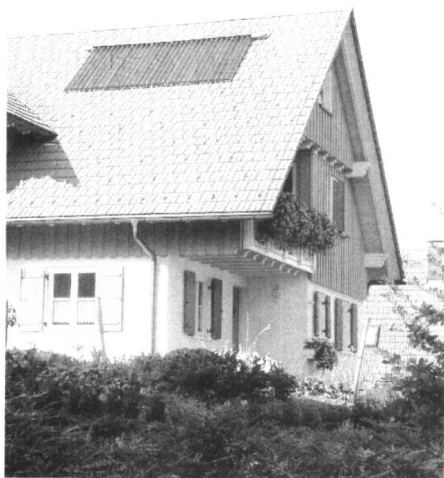
图1-4 集热器安装在屋面上 (桑普公司提供)
