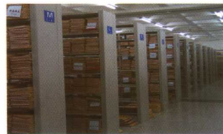
鸥玛数据中心保密室
