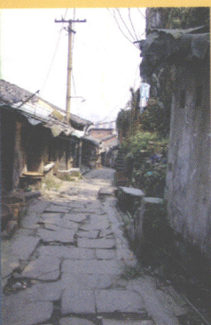
改造前的火井沱棚户区
