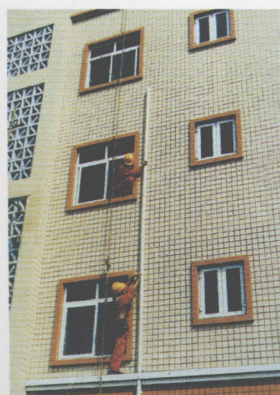
天然气管线安装
