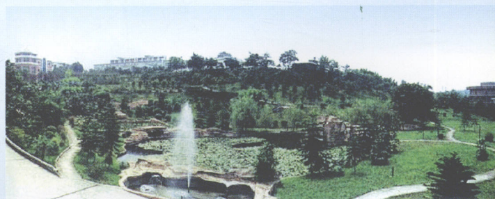
第一水厂厂前区
