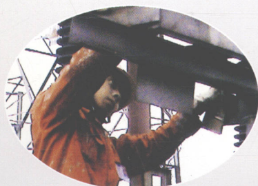
天然气管线防腐
