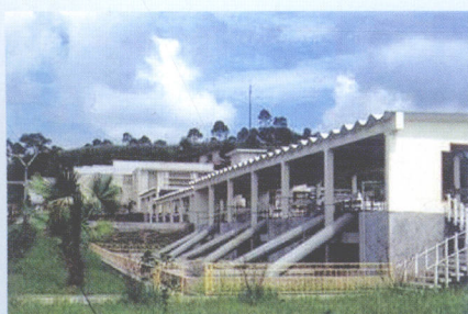
第三水厂反应池
