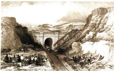
铁路隧道工程
