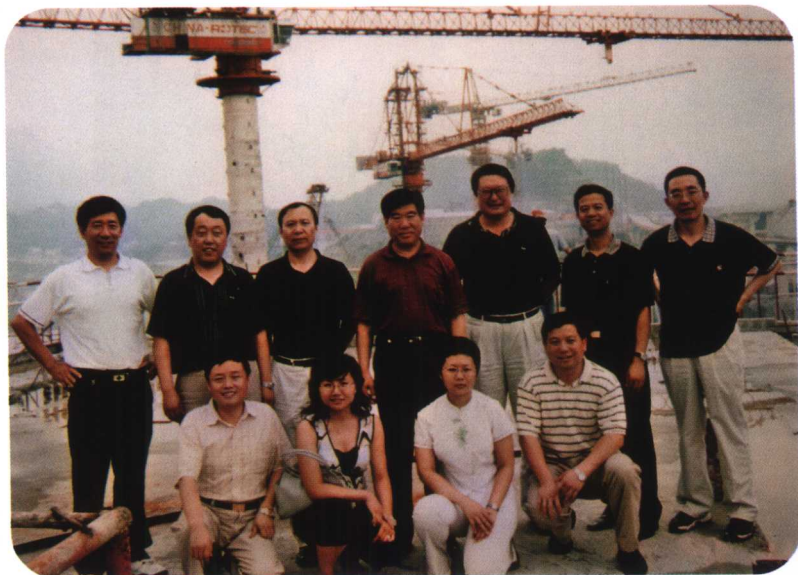
考察三峡工程
