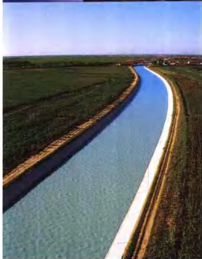
○ 干渠衬砌工程
