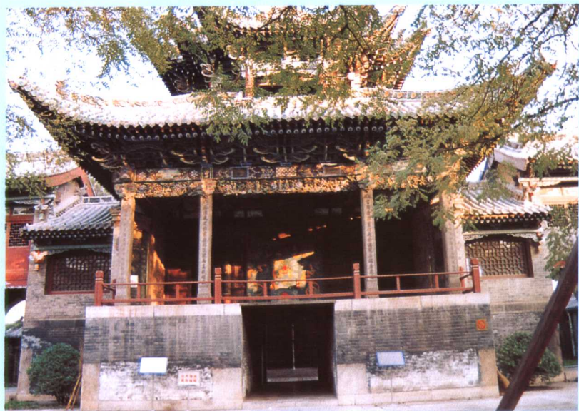
聊城山陕会馆戏楼
