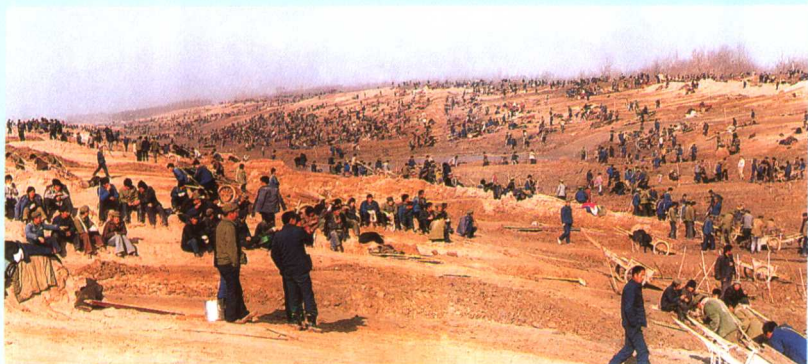
梁济运河开挖河床
