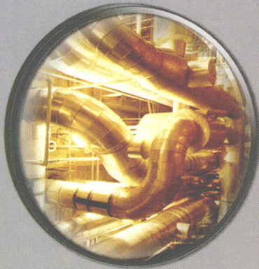
建设中的珲春集中供热项目
