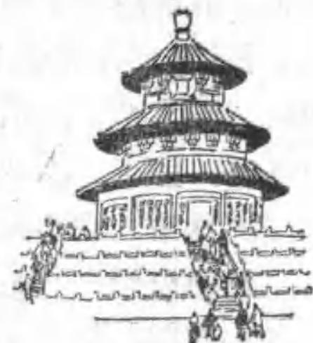
祈年殿为镏金宝顶三重檐建筑，高三十八米，直径三十米。中央四柱代表四季，外圈十二根柱子，分别代表十二个月和十二个时辰。圜丘为三层汉白玉石坛，其北有皇穹宇。皇穹宇前有回音壁和三音石。另外还有皇乾殿、神厨、宰牲亭、七十二长廊、斋宫等建筑物。
