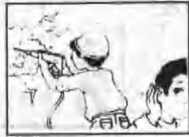
用冲击钻在墙上打孔
