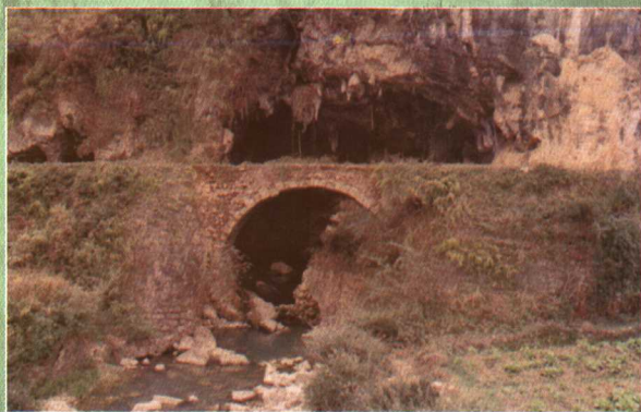
甲良黑洞 洞口古桥
