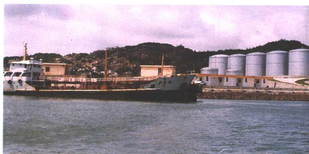
3000 吨级石油码头
