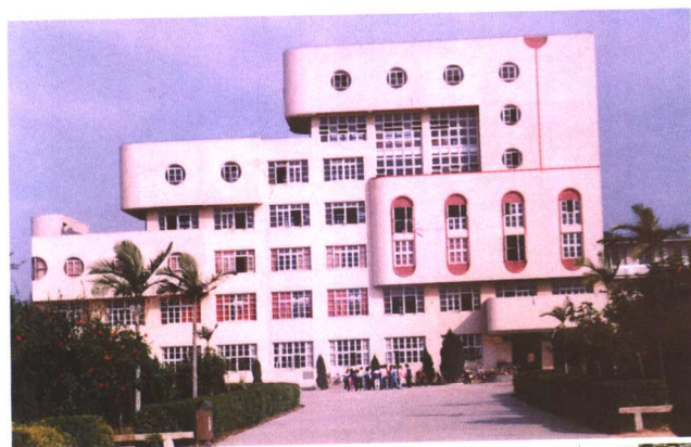
东山一中综合大楼
