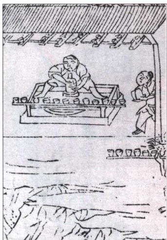
▲ 清代刻印的《景德镇陶录》卷一图说中，形象地描绘了当时制瓷工艺的流程。这是一幅工匠拉坯成型图画，景德镇传统制瓷作坊中，仍然保留了这种工艺设备和技艺。
