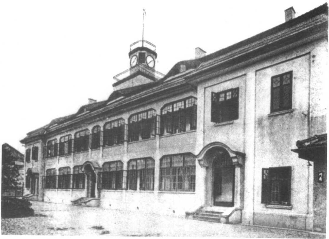
厚生纱厂办公用房（右侧为门房）
