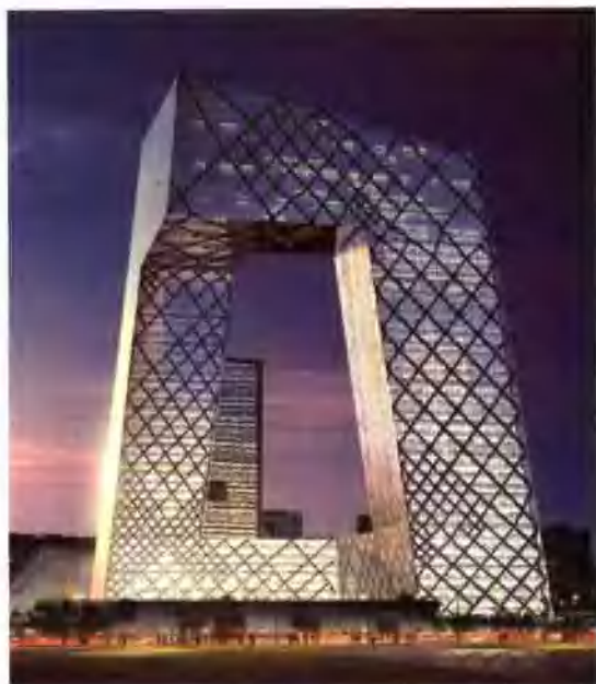
中国中央电视台主楼
