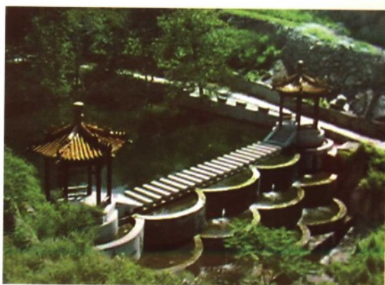
位于妙峰山镇岭角村的岭角双亭坝
