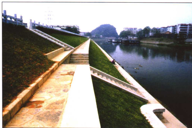
桂林市城北防洪堤
