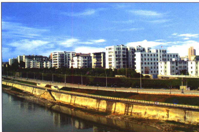
柳州市防洪堤的三中堤段
