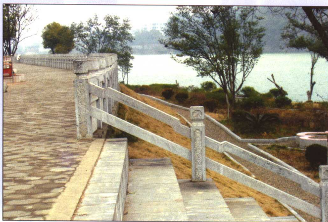
全州县城区防洪堤三江口堤段
