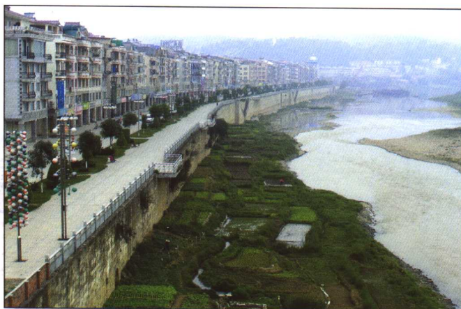
百色市城区防洪护岸工程
