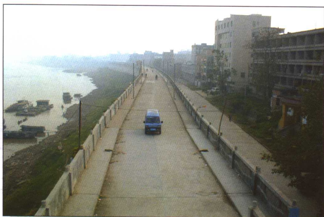
苍梧县城区防洪堤段
