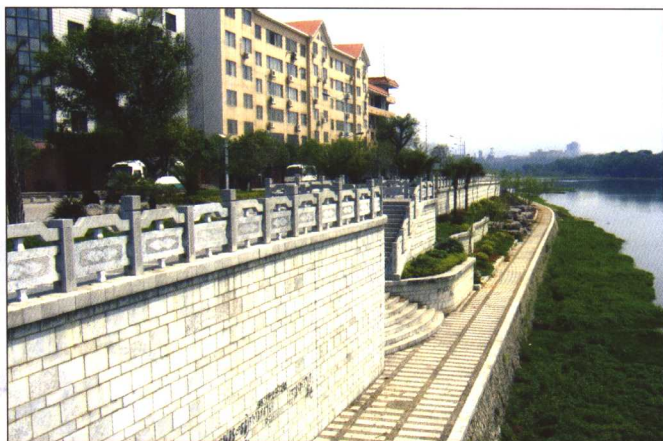
灵川县城区防洪堤一角
