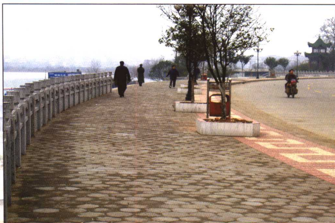
全州县城防洪堤一角
