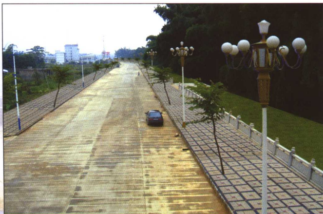
贺州市城区防洪堤堤顶路面
