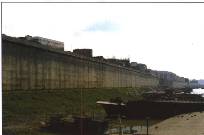
藤县城区河西防洪堤
