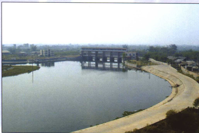
玉林市城区防洪工程南江排洪闸
