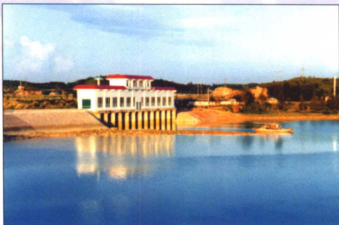
防城港市沙潭江堤及涵闸
