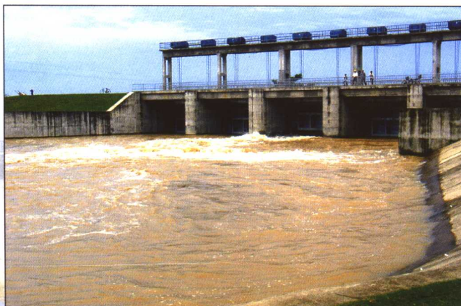
合浦县城区周江口防洪防潮闸
