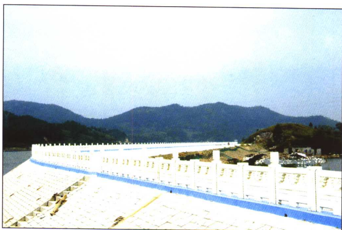
防城港市马正开海堤段
