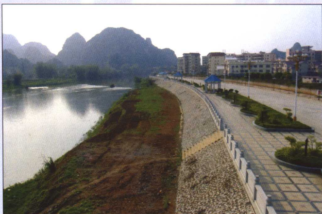
贺州市城区防洪堤段
