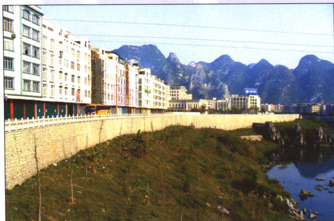
河池市龙江防洪堤的市政府堤段
