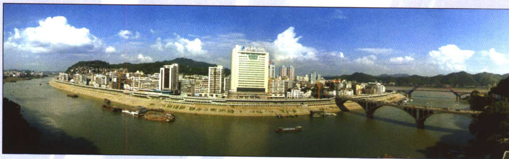
梧州市河东防洪堤全景
