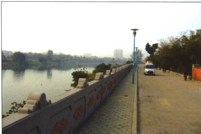
钦州市钦江西 I 堤
