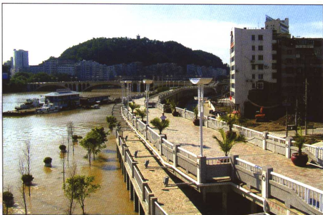
2004年7月，梧州市河东防洪堤桂江段在22.65m洪水位时的景象
