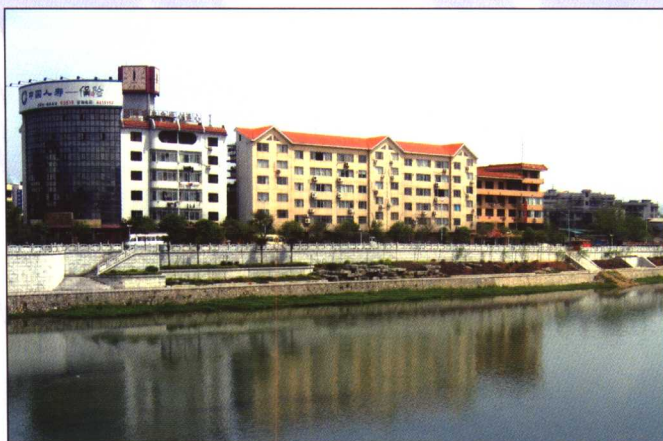
灵川县城防洪堤甘棠江大桥至县医院堤段
