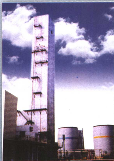
● 安装在福建三安钢铁集团公司的20000 \text{m}^3/\text{h} 空分设备
