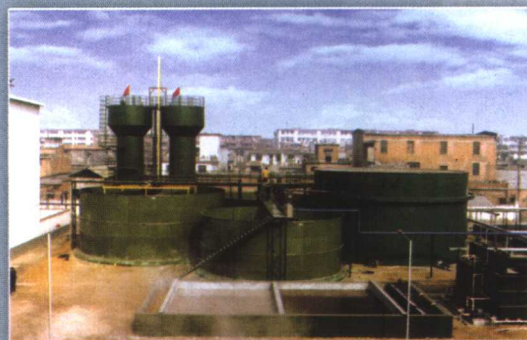
● 南阳第二制药厂污水处理工程
