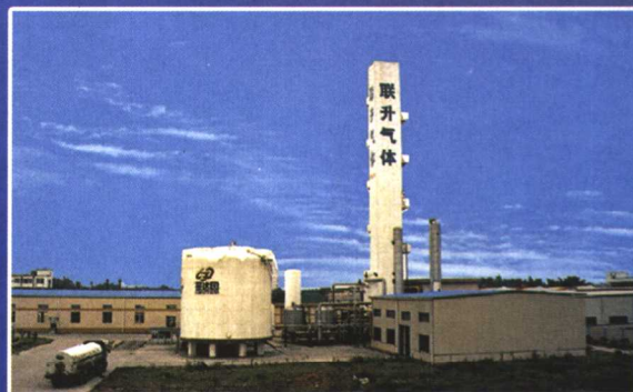
广东清远联升公司3000m³/h液体空分装置全景
