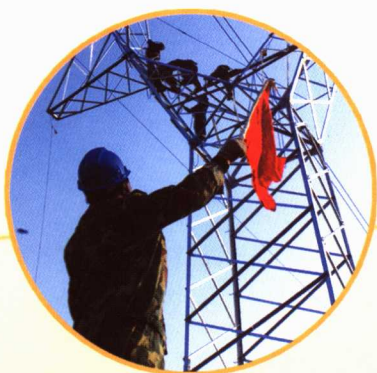
电网建设施工现场
