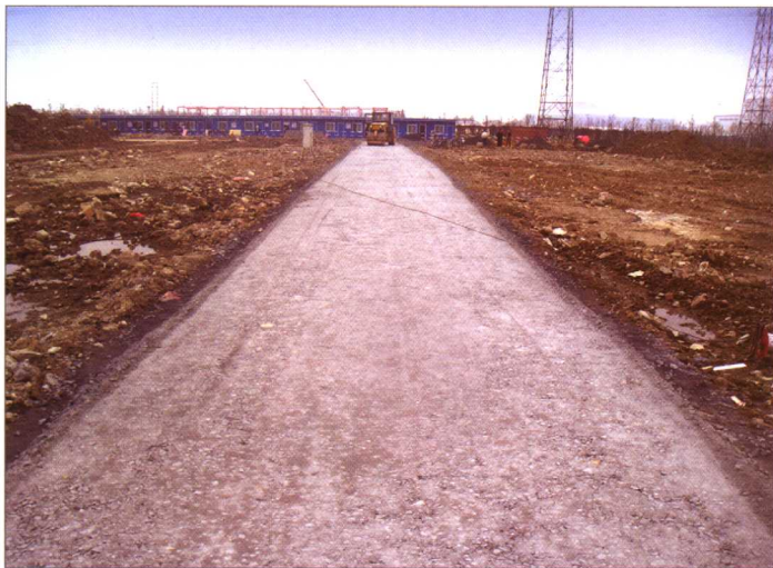
图 1-3 二灰结石铺设碾压
