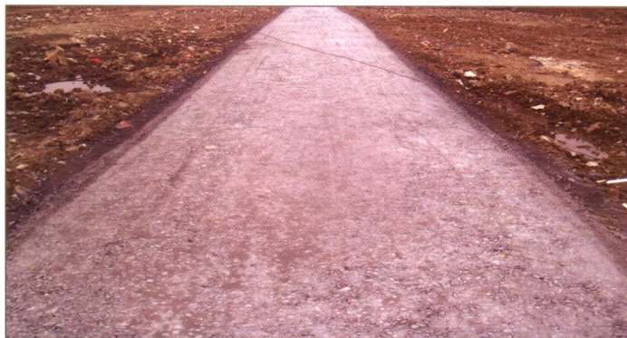
图 1-5 道路灰土地基
