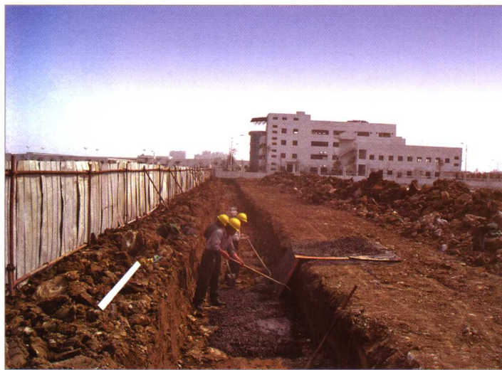
图 1-4 砂石和碎石分层铺设
