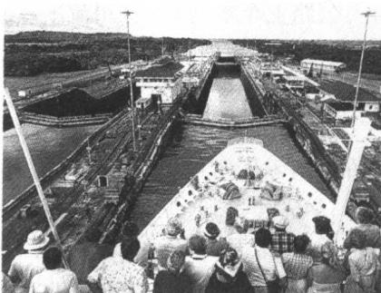
横贯中美洲的巴拿马运河，虽然只有83千米长，却沟通了太平洋和大西洋这两个最大的海洋之间的交通。这是一条高于海平面的人造河，宽91~204米，水深12.6~26.5米，沿线有6座船闸用来改变水位。这条运河通航后，每年可通过约1.5万艘船舶。巴拿马运河在地理位置上十分重要，但运河的规模却限制了航船的吨位，只能通行4万~5万吨级的船只。相比之下，连接地中海和红海的苏伊士运河，则是世界上最繁忙的通海运河，它沟通了欧、亚、非三大洲的海上国际贸易，使航行时间、距离大大缩短。苏伊士运河全长193.5千米，经过扩建后，可通航吃水深达16米、满载15万吨（或空载37万吨）的大型轮船。
