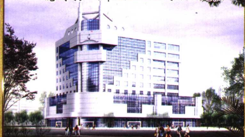
巍峨的广西中烟工业公司办公大楼
