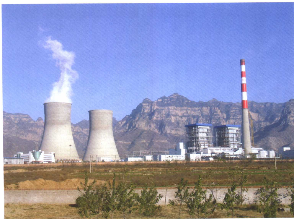
投产我国首台国产 60 万千瓦超临界机组的华能沁北电厂
