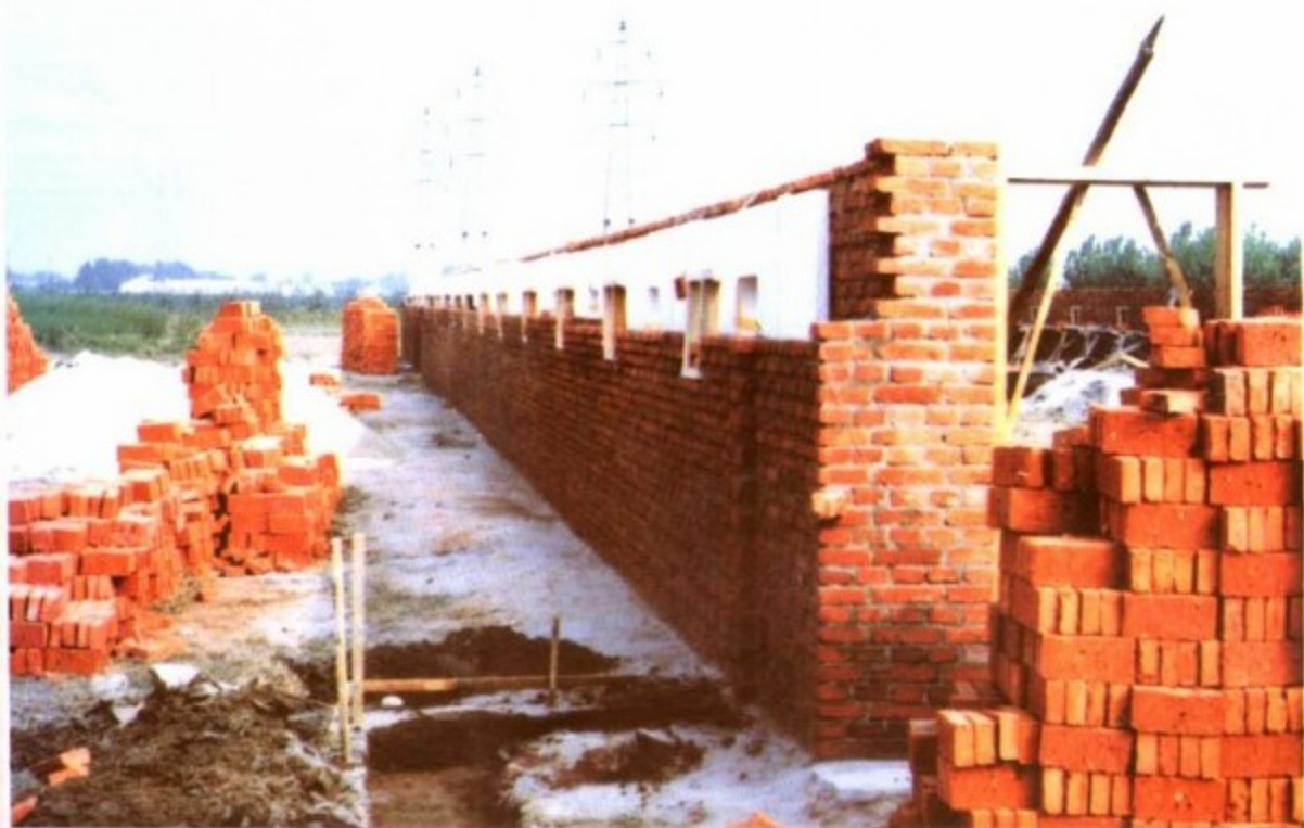
砌墙安装通风窗
