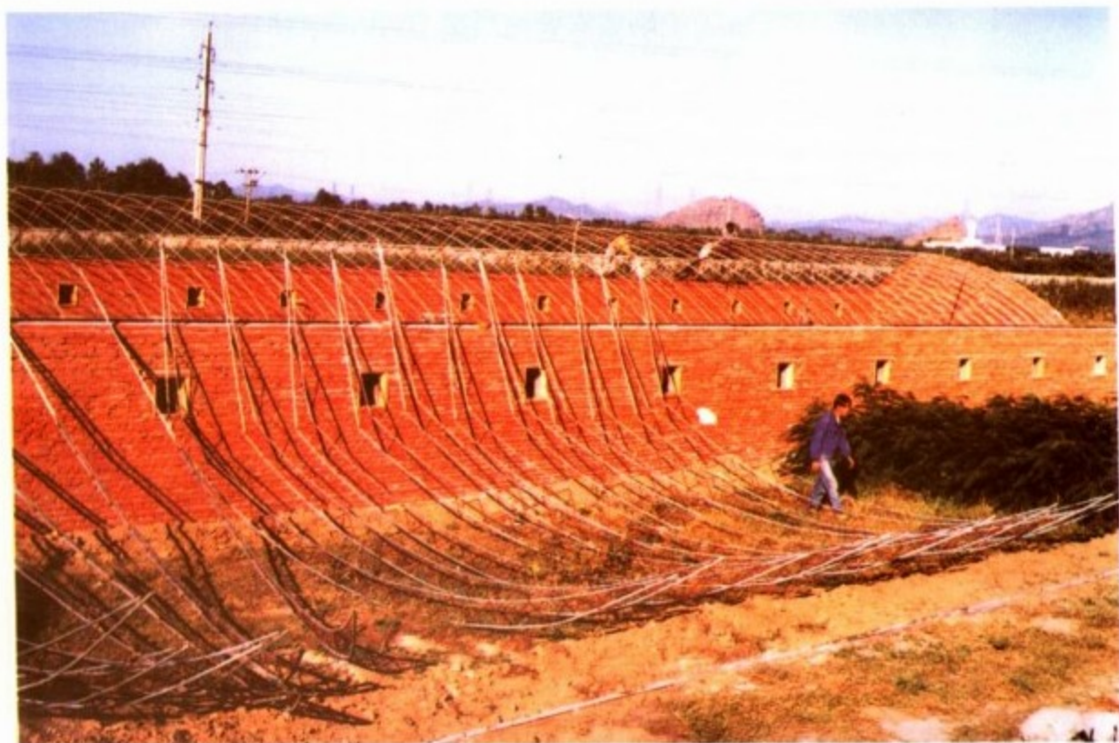
安装前屋面骨架
