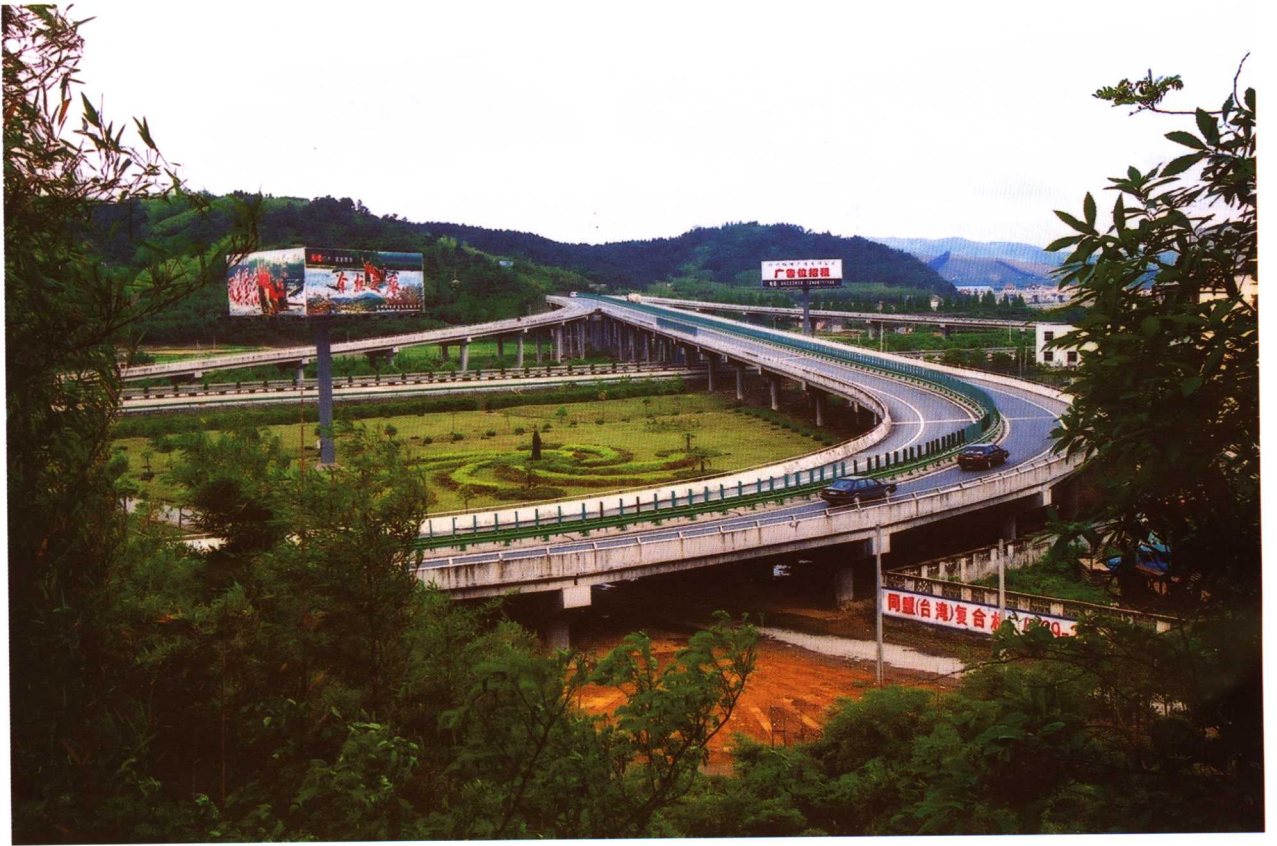
04省道彭公立交桥
