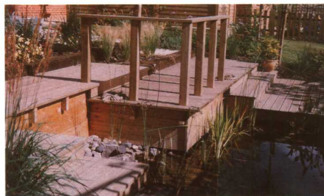
上图：这张图片显示了平台的高差变化和供人倚靠的栏杆，人们可以靠栏杆观赏下面的水池。
