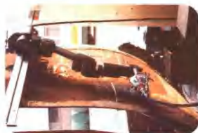
水轮机修复机器人正在进行打磨工作
