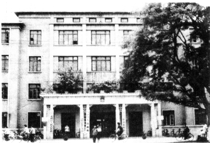
洛阳市老城区人民政府办公大楼
