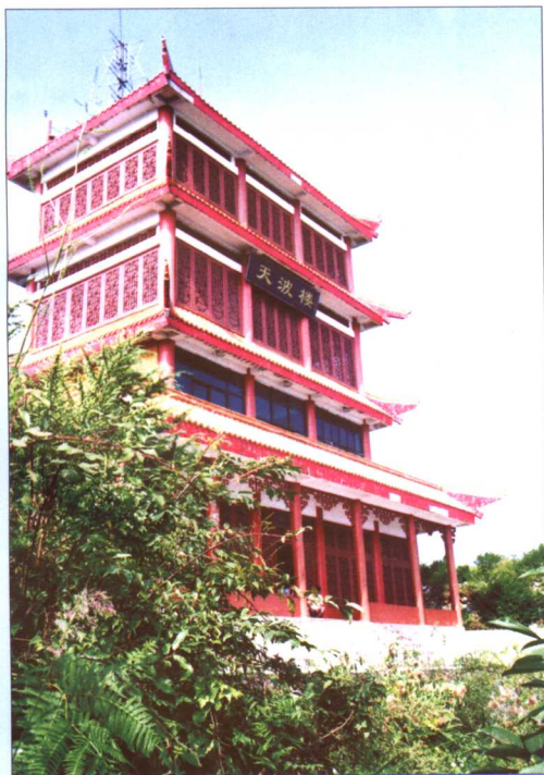
坐落于朝阳山的六盘水人民广播电台调频发射机房
