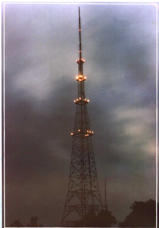
1992年6月落成的高125米的六盘水电视发射铁塔
