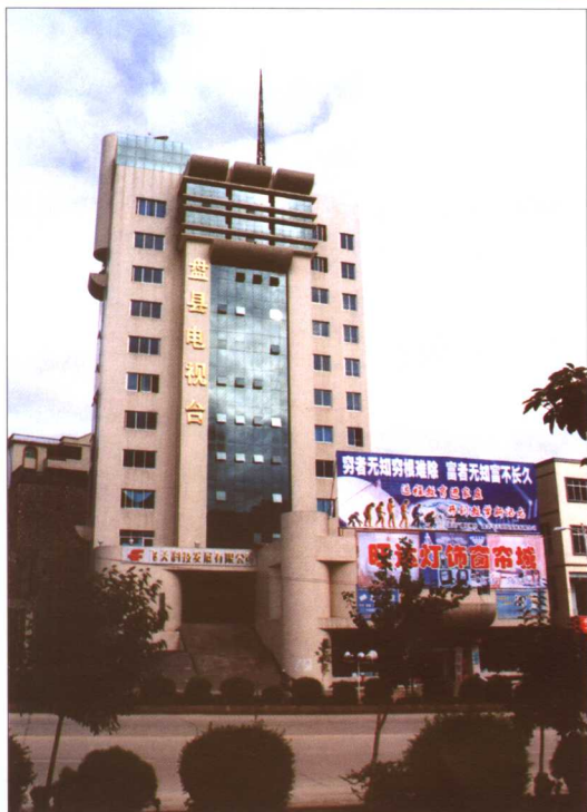
2000年底建成高12层的盘县广播电视大楼
