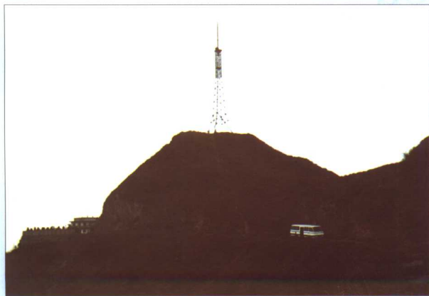
794台高64米的发射铁塔
