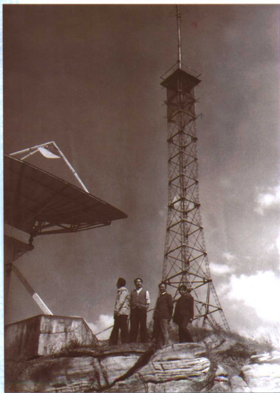
建于1985年高50米的盘县电视发射铁塔
