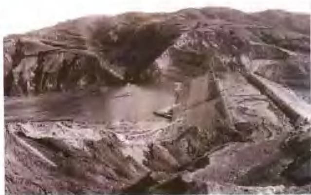
1973年 山西临县曹家岭 水坠坝施工中
