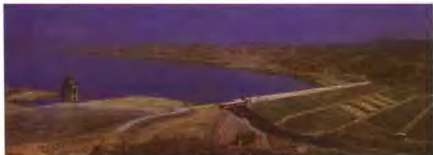
1962年建成的60米水中填土 坝工程——汾河水库
