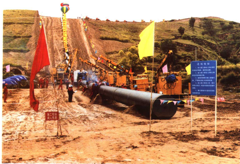
管道铺设现场
