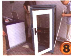
安装机柜其他三面的 挡板
