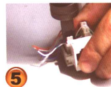
用打线工具把芯线卡入线槽
