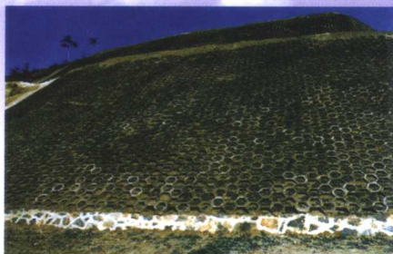
鹿泉矿山环境治理示范区
