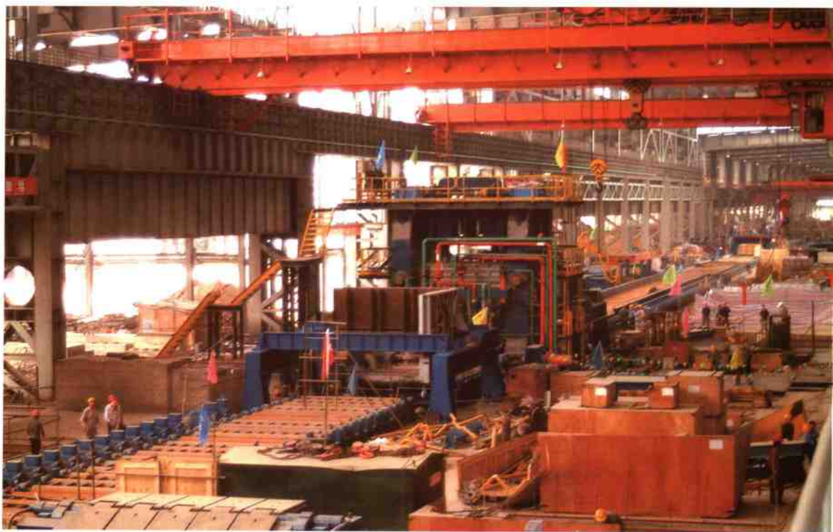
120t 转炉—炉卷轧机工程
