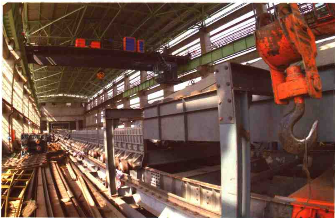
360m² 烧结机工程
