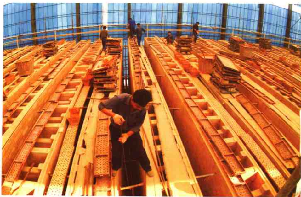
6m 焦炉工程
