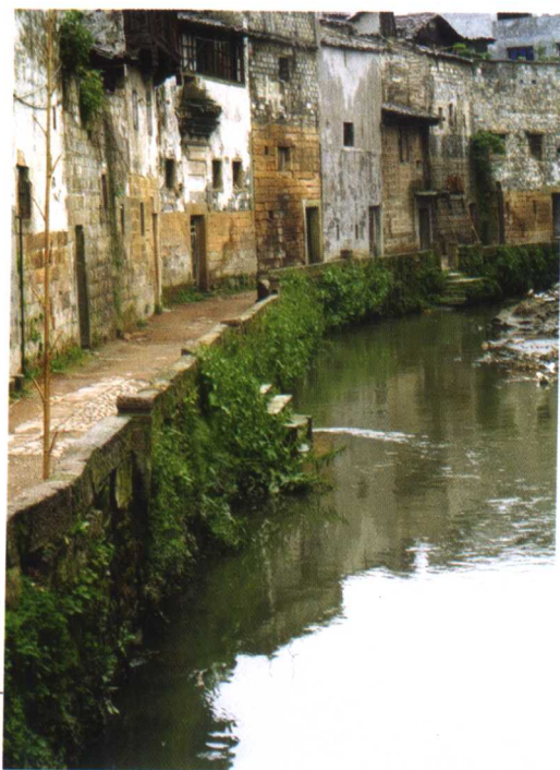
惠济渠水环流河口城区
