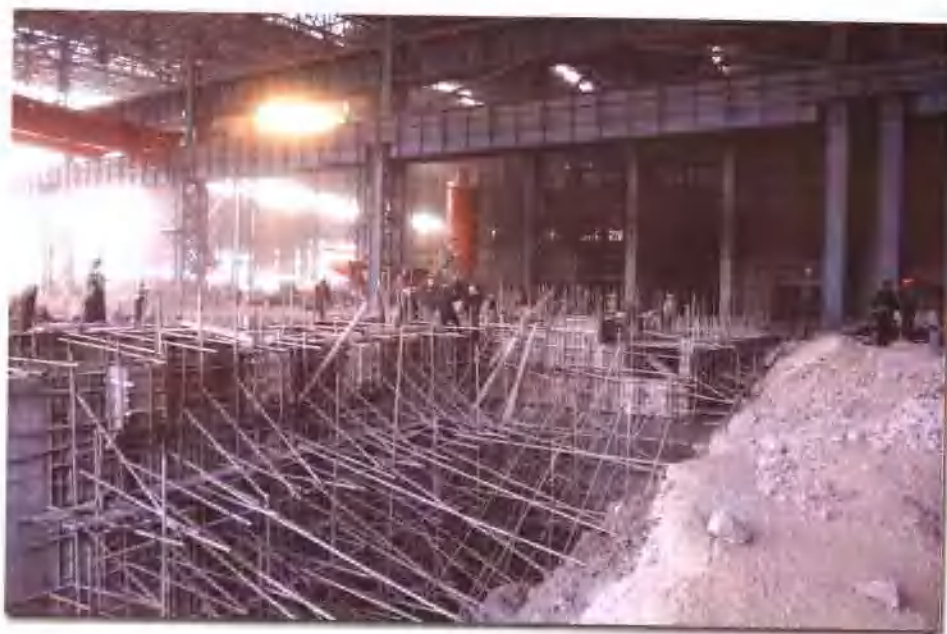
2004年8月，集团公司决策抢建对莱钢结构调整和工艺完善具有重大意义的3号大板坯连铸机。8月15日，土石方开挖；10月3日，土建开工；12月5日，设备开始安装。
