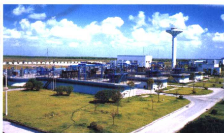
上海白龙港污水处理厂,荣获中国市政金杯示范工程奖
