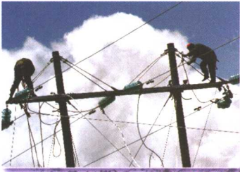
电气化线路架设
