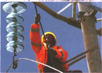
藏北当雄县境内架设35千伏供电线路
