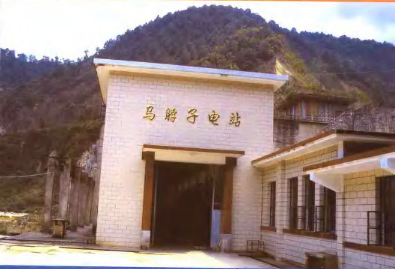
位于高乡槽子村前 装机容量 3650 千瓦
