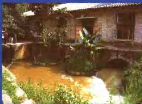
观音水电站 装机 650 千瓦
