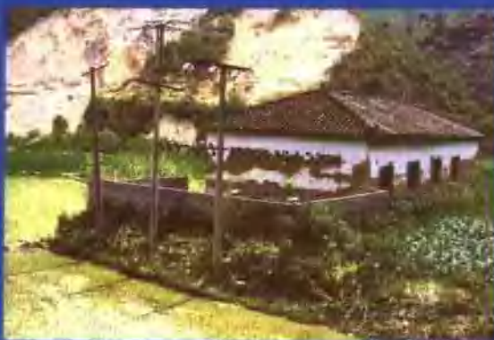
三家水电站 装机 150 千瓦
