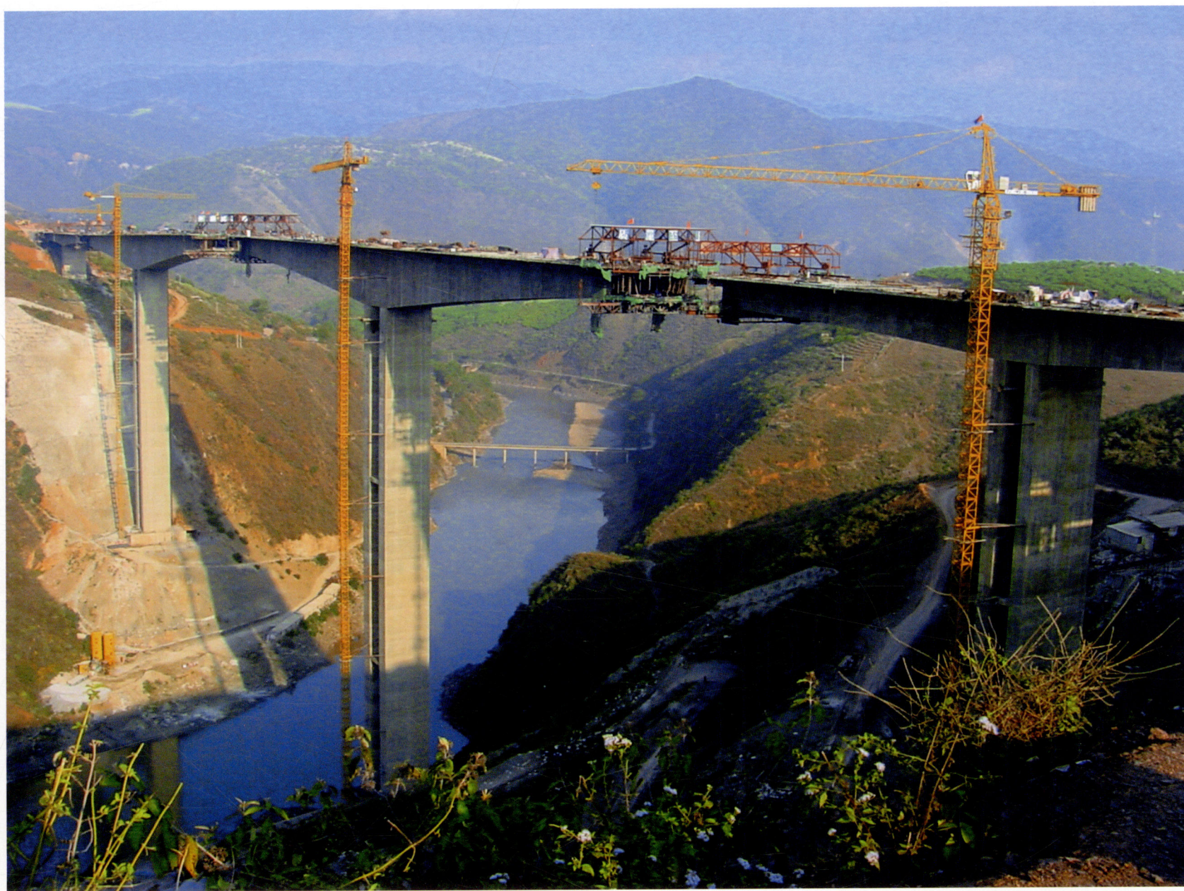
红河大桥主跨265m，合拢误差仅为2cm。123.5m的连续刚构柔性高墩，施工误差也在1cm以内
