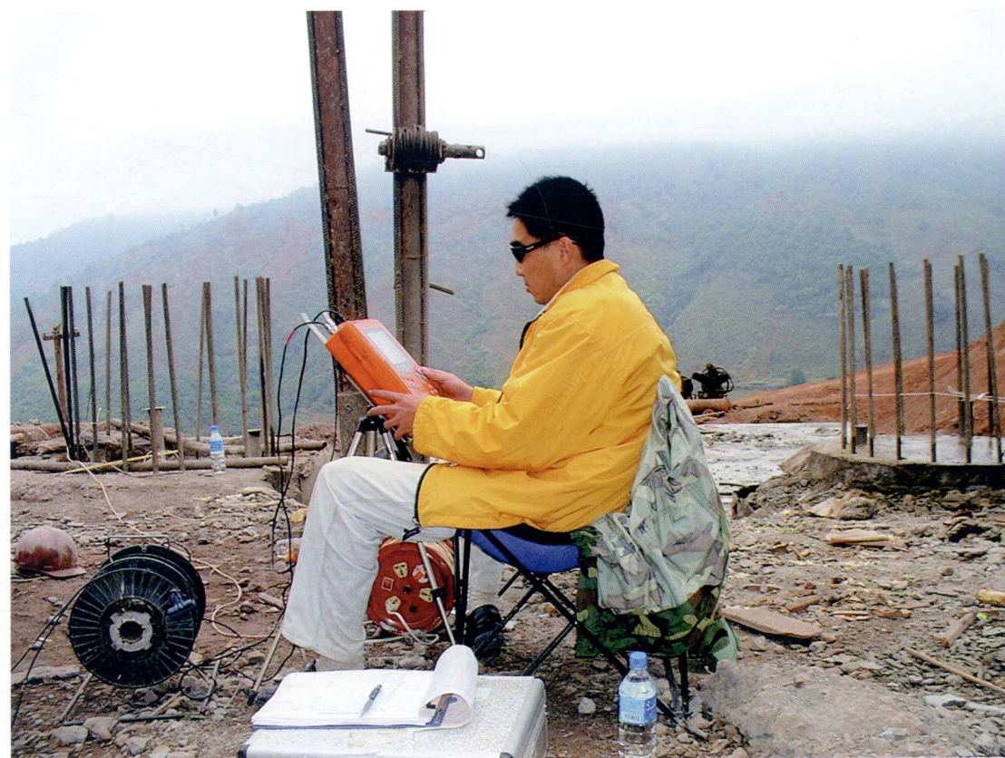
桥梁桩基检测
