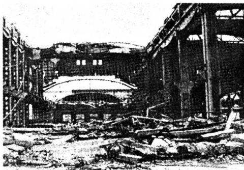
图 1.12 构件连接不牢丧失整体性
