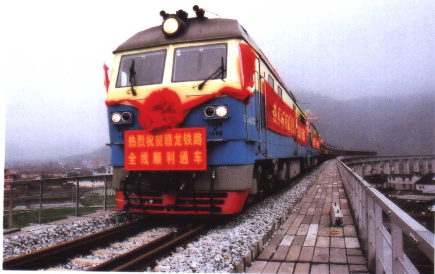
▲2005年4月1日，赣龙铁路全线通车
