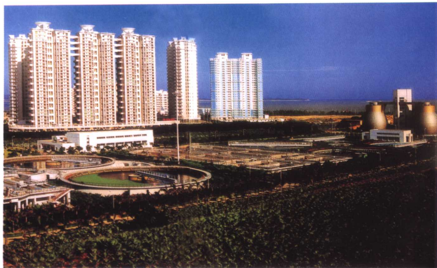
▲ 厦门污水处理工程
