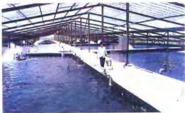
图4 工厂化养鳗池
