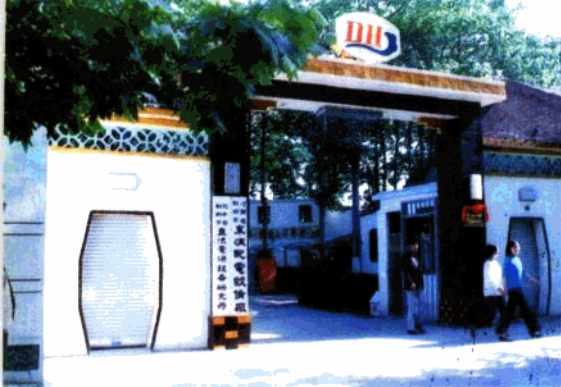
东海配电设备厂
