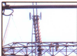
伞裙用在500kV进线侧串瓶上
