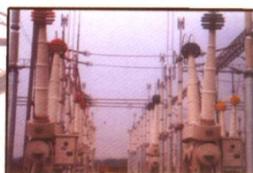
RTV涂料用于500kV设备
