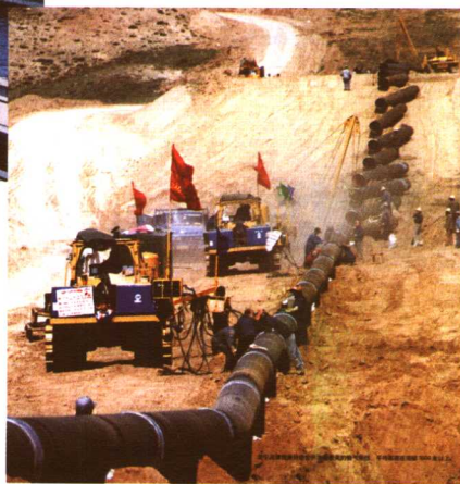
管线钢用于西气东输工程
