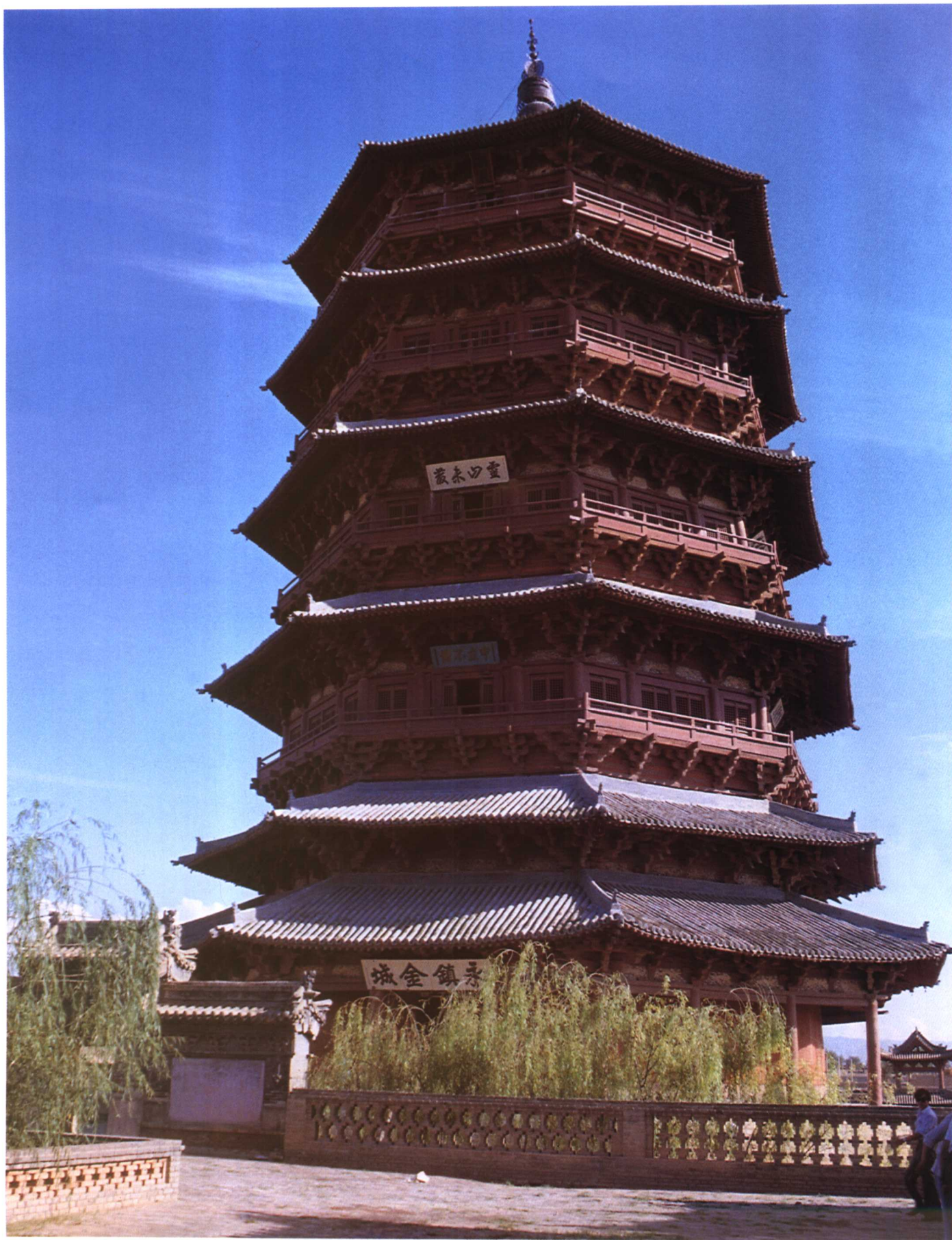
▲ 中国传统木结构建筑——山西应县木塔外观
