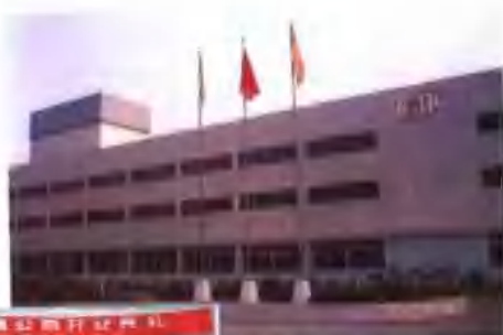
壮观的许昌天昌国际烟草有限公司大楼
