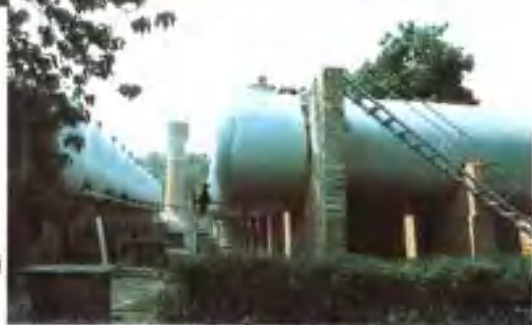
长葛商业局——长葛 石油公司 7000 吨的 油库一角
