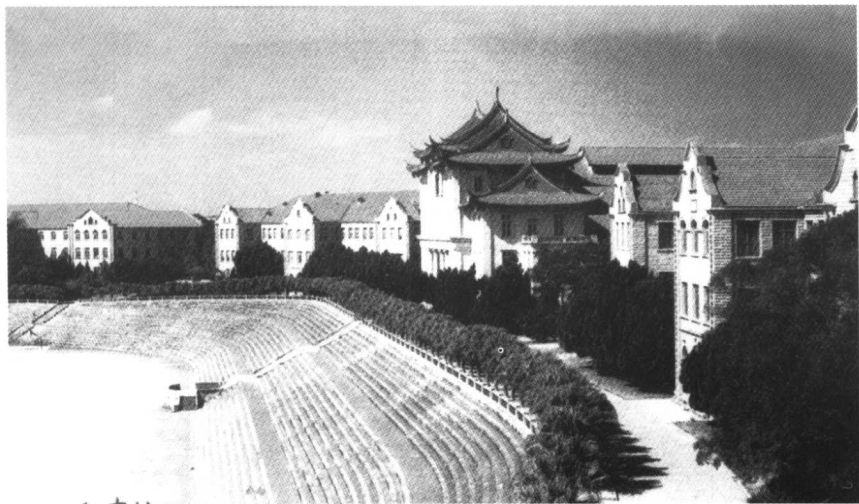
1955年新建成的建南大会堂楼群
