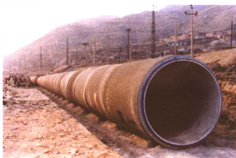
引黄工程使用的PCCP ——预应力钢筒混凝土管
