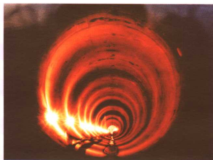
引黄工程引水隧洞
